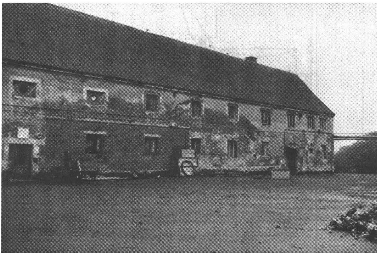
Obr. 6: Severovýchodní část tvrze, stav roku 1992
