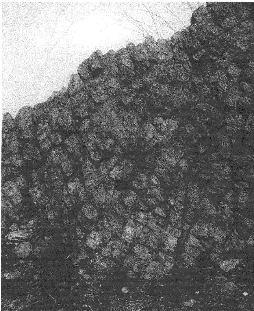
Fot. 3 - Čela sloupců čediče ve stěně vrcholové zdi Janských Kamenů.
