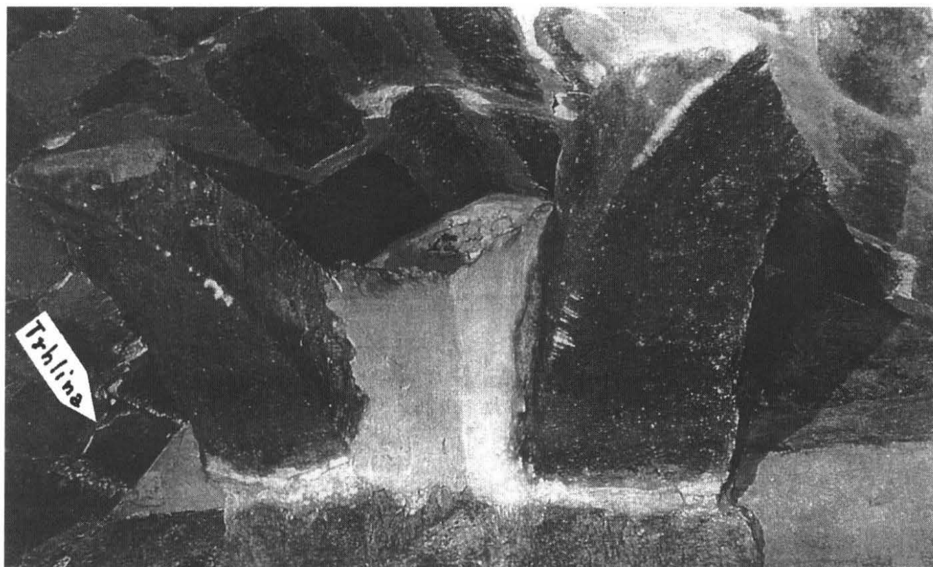
Foto 5 Systém opěrných žeb ve sklepe
