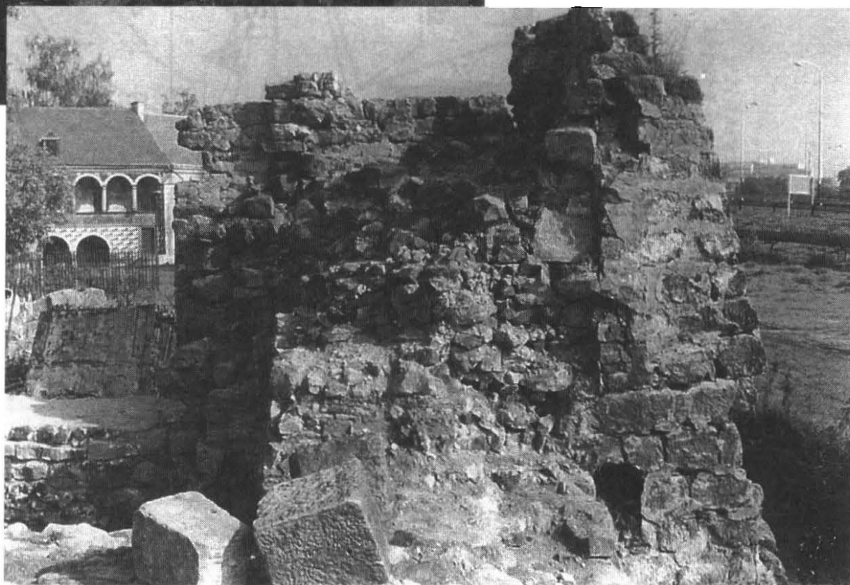
Foto 14 Fragmenty zdiva s opěrovými pilíři
