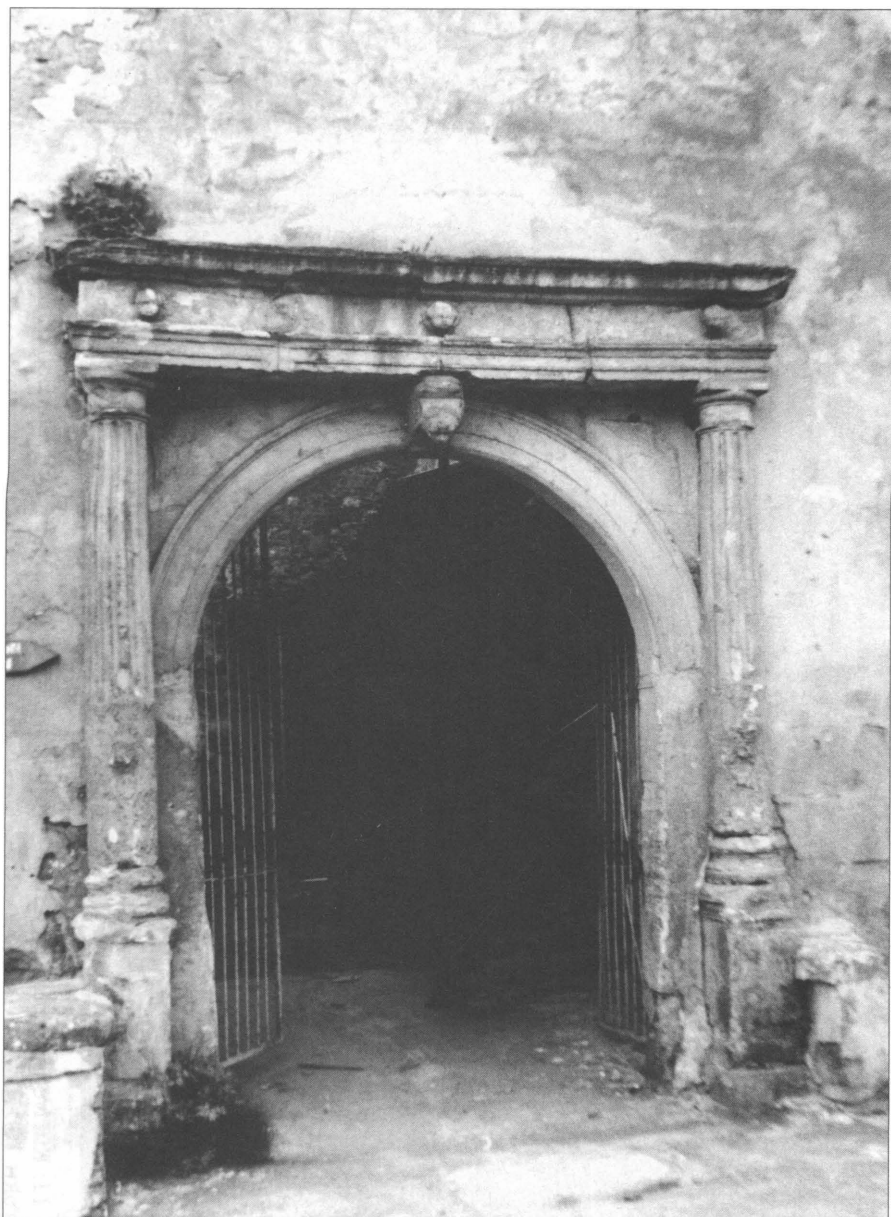
Obr. 12: Kuřívody, vstupní raně barokní portál v přízemí bývalé věže.
