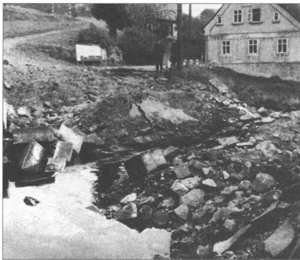
Snímek 5: Zbytky silničního mostu v Dolním Podluží po destrukci 30.9.1938
