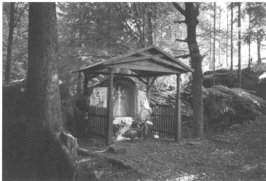
Obr. 1. Lipnická kaple po opravě roku 2002. Foto p. Bik, Lesní závod Rumburk.
