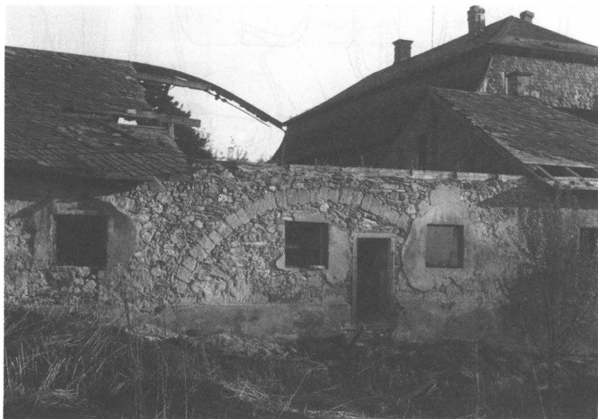
Obr. 2. Bývalá stodola a objekt čp. 4 před pozdějším stržením mansardové střechy a 1. patra v Okrouhlé na jaře 1978. Foto autor.
