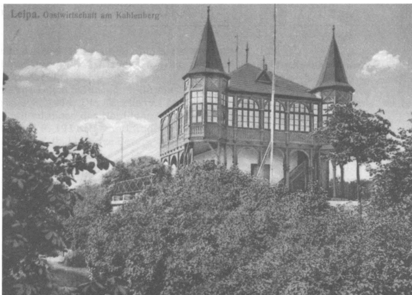
Obr. 2. Dobová pohlednice Holého vrchu s restaurací. Zdivo kaple tvoří přízemní část stavby.
