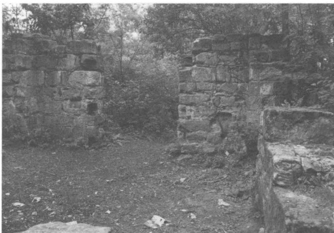
Obr. 3. Zřícenina kaple na Holém vrchu. Pohled z vnitřku kaple na bývalý vchod.
