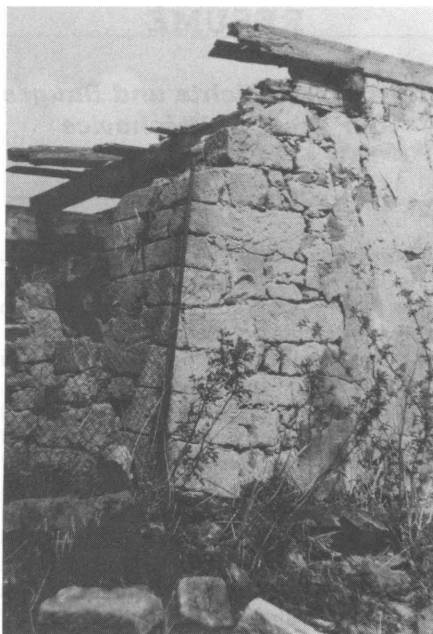
Obr. 13. Útěchovice (okr. Česká Lípa), drobný opěrný pilíř v jihozápadním nároží tvrze. Stav v roce 1985, foto autor.
