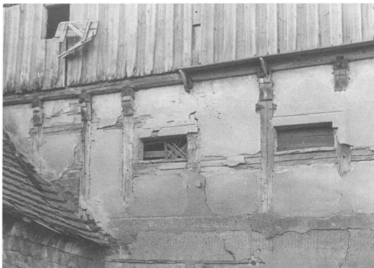
Obr. 9. Útěchovice (okr. Česká Lípa), detailní pohled na sloupky hrázděné konstrukce patra zakončené vyřezávanými konzolkami. Stav před rokem 1978, originál uložen ve Vlastivědném muzeu a galerii Česká Lípa.
