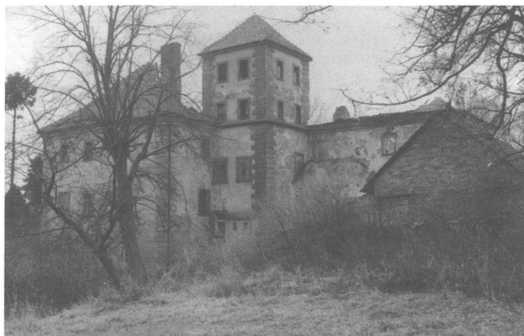
Obr. 6. Velký Valtínov (Česká Lípa), západní průčelí tvrze a zámku se schodišťovou věží. Snímek dokumentuje tehdy již částečně zřícenou střechu objektu. Stav na podzim 1983, foto Miroslav Fuchs.
