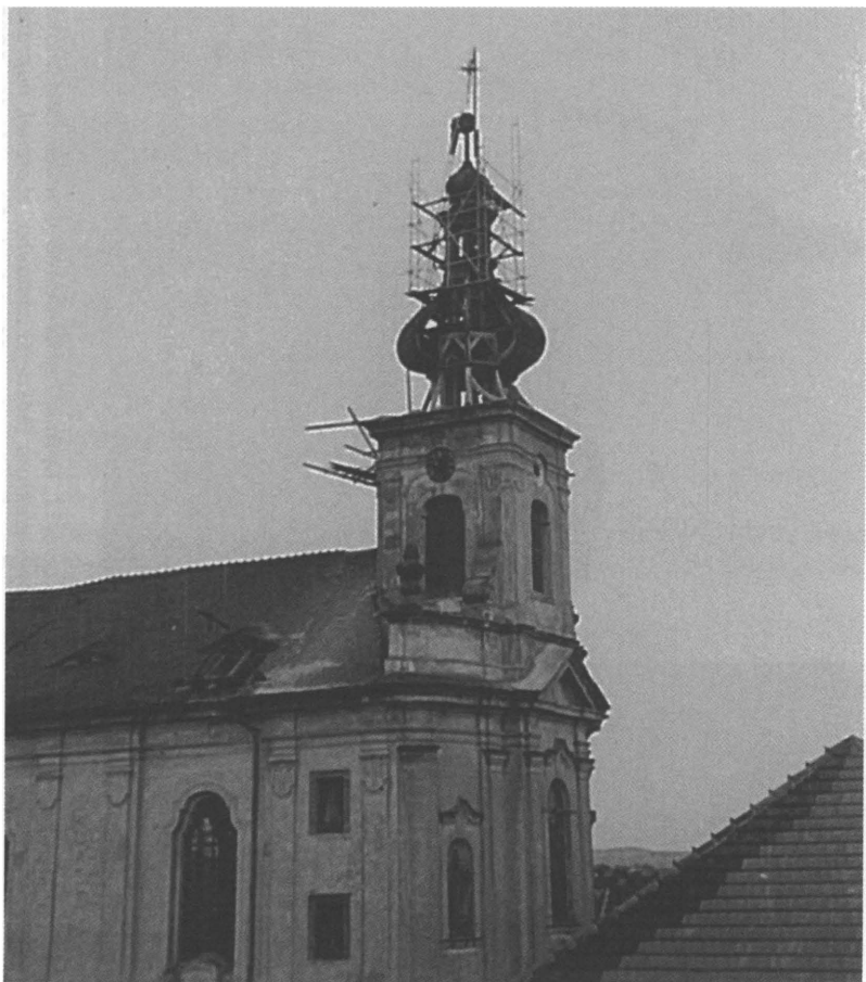
Obr. 12. Oprava krovu a střechy, foto nejspíše 1937 (uloženo do makovice kostelní věže).
