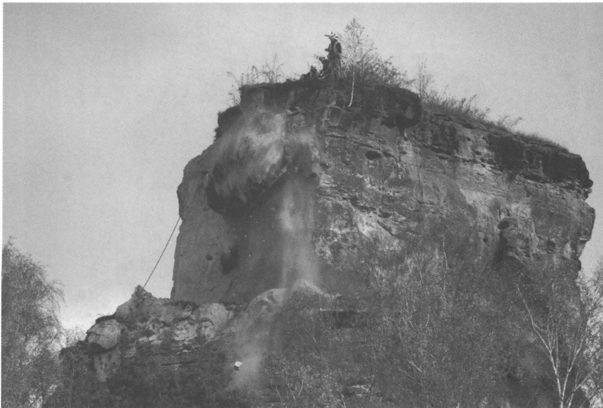
Obr. 10. Shoz nestabilního bloku odbornou firmou dne 30. 10. 2009. Foto H. Kaňková.
