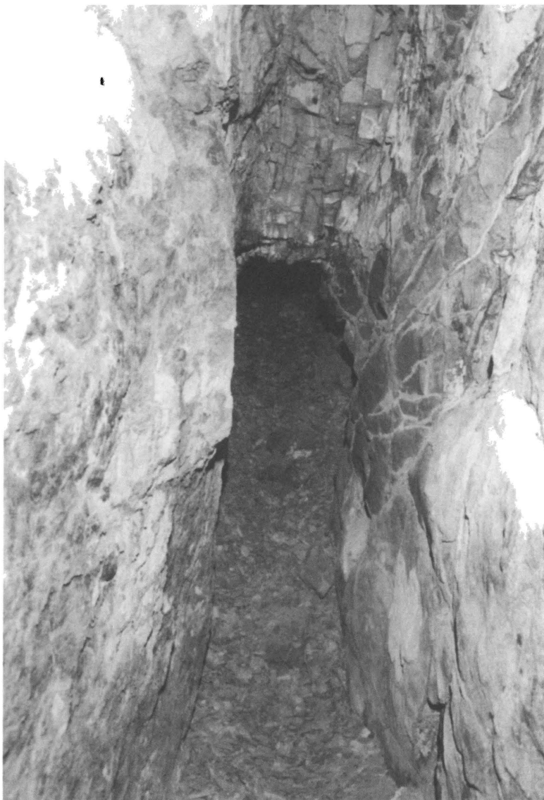
Obr. 6. Štola č. 1, pohled směrem k SV k zasutěnému vchodu. Vlevo pískovec, vpravo polzenit. Ve stropě je patrná rezavě hnědá, železem obohacená přikontaktní zóna polzenitu. (Foto V. Štěpánský).
