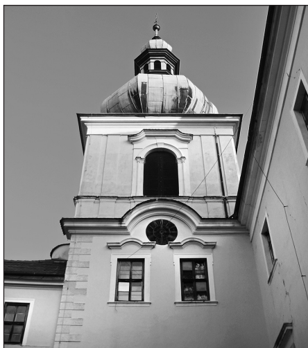
Obr. 4. Doksy, zámecká věž, západní strana. Foto autor 13. 1. 2014.
