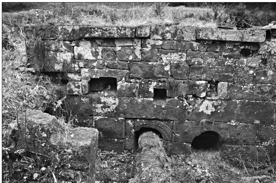
Obr. 8. Návodní stěna brusírny se starším (vpravo) a mladším otvorem pro hřídel vodního kola. Foto I. Peřina, leden 2013.
