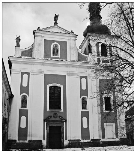
Obr. 1. Bělá pod Bezdězem, kostel sv. Václava, průčelí obrácené směrem k severozápadu. Foto autor 3. 2. 2014.
