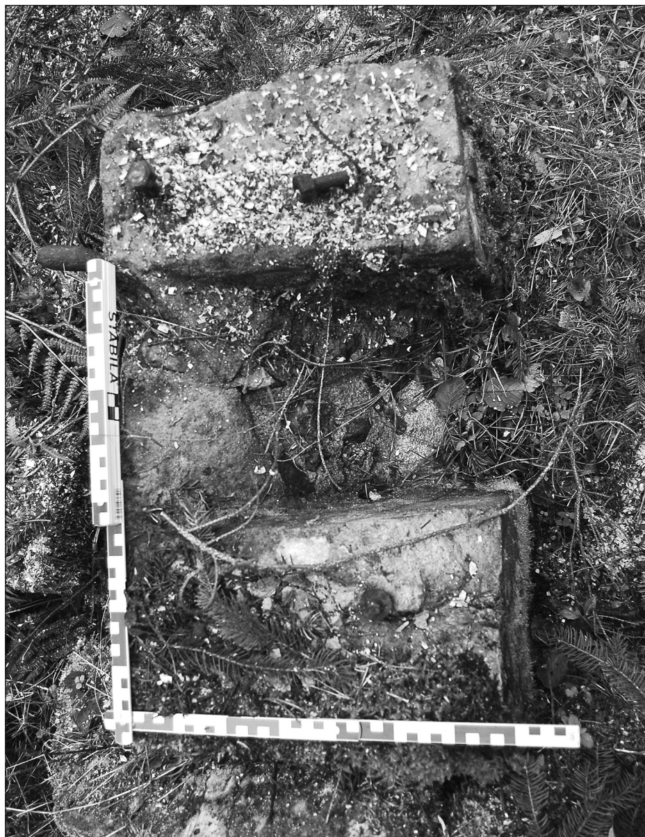
Obr. 10. Přízemí brusírny – torzo fundamentu pro uložení transmisy (kotvení ložiska pomocí šroubů + drážky pro řemenici). Foto I. Peřina, listopad 2012.
