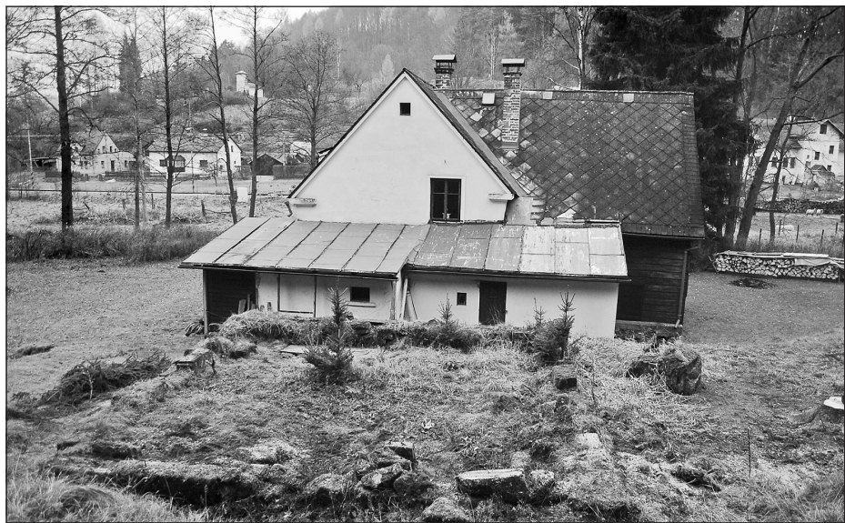
Obr. 3. Celkový pohled od jihu na torzo brusírny, mezi základovým zdívem vpředu fundament pro transmisi. Vzádu obytný dům. Foto I. Peřina, listopad 2012.
