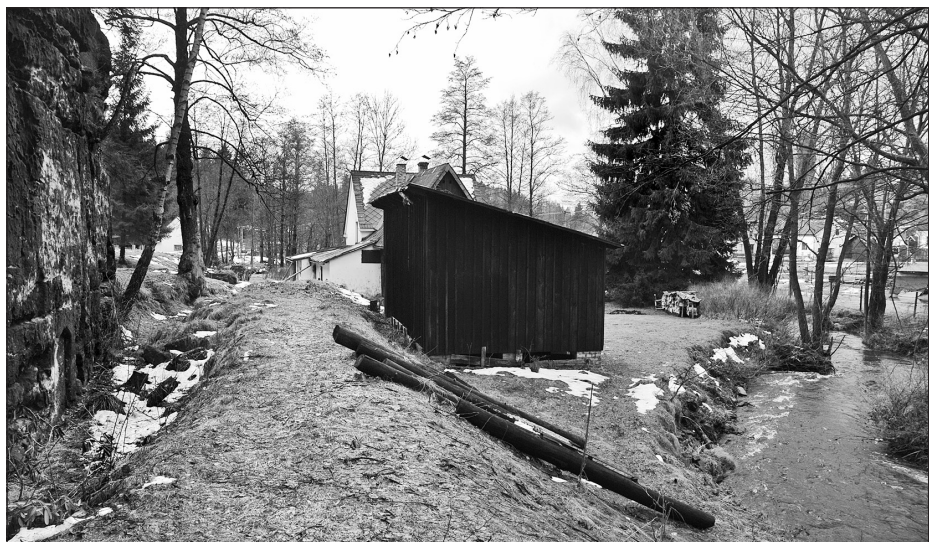
Obr. 2. Pohled na náhon v úseku podél skalní stěny, v pozadí usedlost č. p. 12H, vpravo obytný dům, základy brusírny jsou vlevo, Foto I. Peřina, leden 2013.
