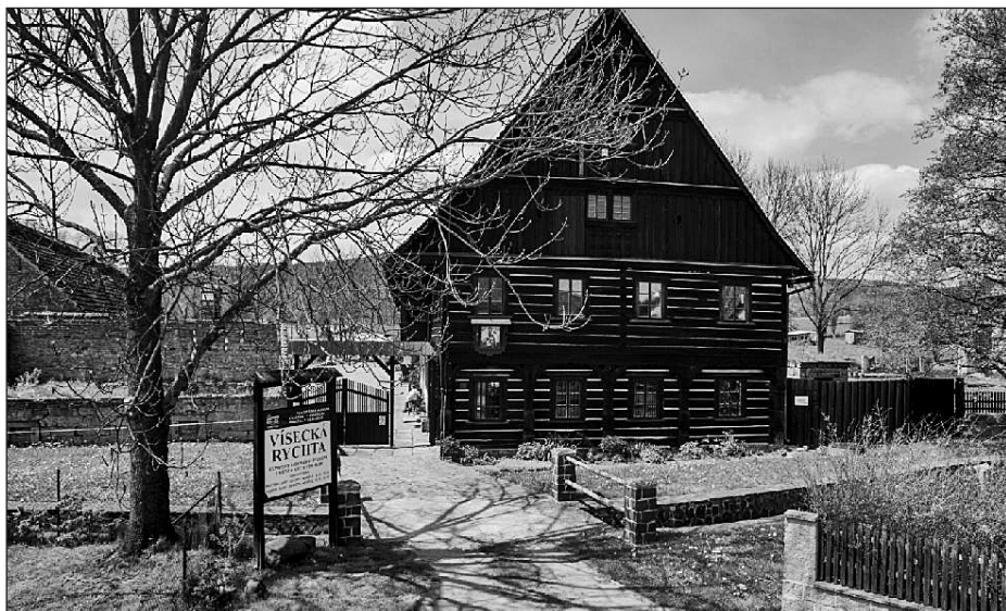
Obr. 5. Vstupní část areálu Vísecké rychty, současný stav (foto Vladimír Štěpánský).
