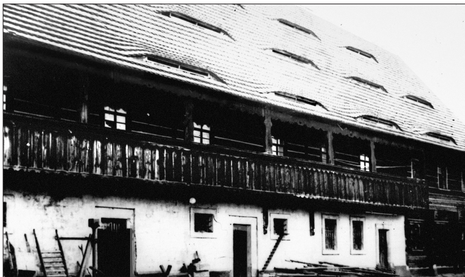
Obr. 2. Pohled od západu na nádvoří průčelí s roubenou obytnou částí a zděnou hospodářskou částí domu ve 30. letech 20. století (VMG, fotoarchiv).
