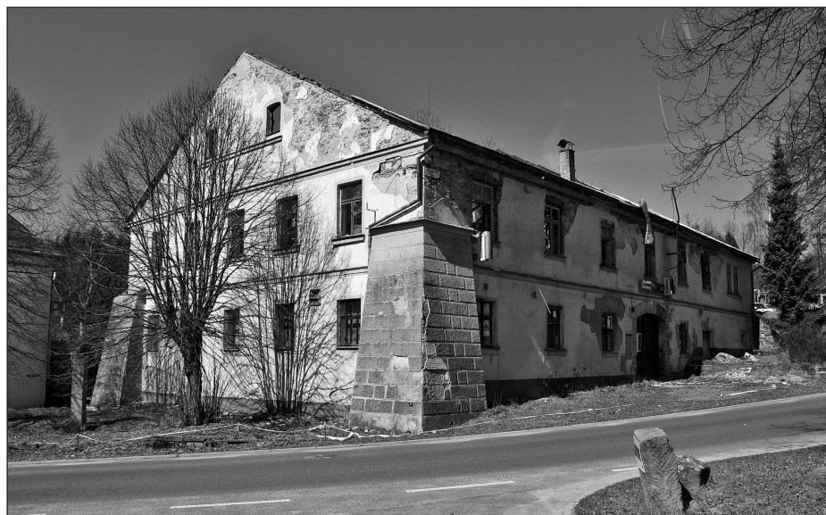
Obr. 12. Dnešní stav vyhořelé budovy hostince. Foto J. Panáček 2017.
