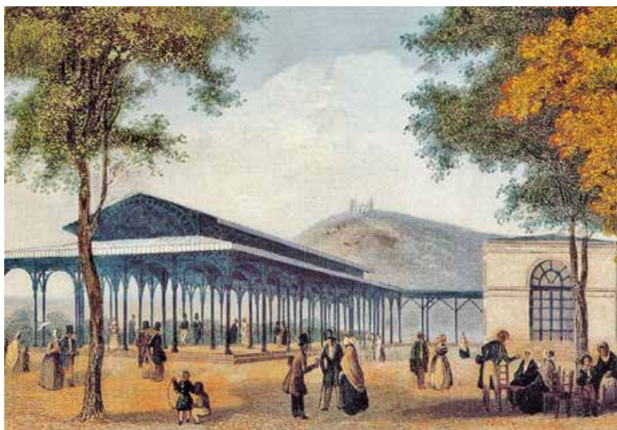
Obr. 11. Pohled na lázeňské objekty v Bad Kissingen, okolo 1850. Stadtarchiv Bad Kissingen ( https://de.wikipedia.org/wiki/Bad_Kissingen#/media/Datei:Brunnenhalle_05 ).
