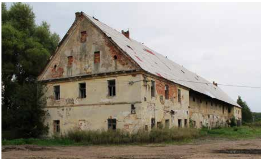
Obr. 13. Stružnice (okr. Česká Lípa), západní část dochované budovy tzv. Horního dvora čp. 154 od jihozápadu (foto autor 2024).
