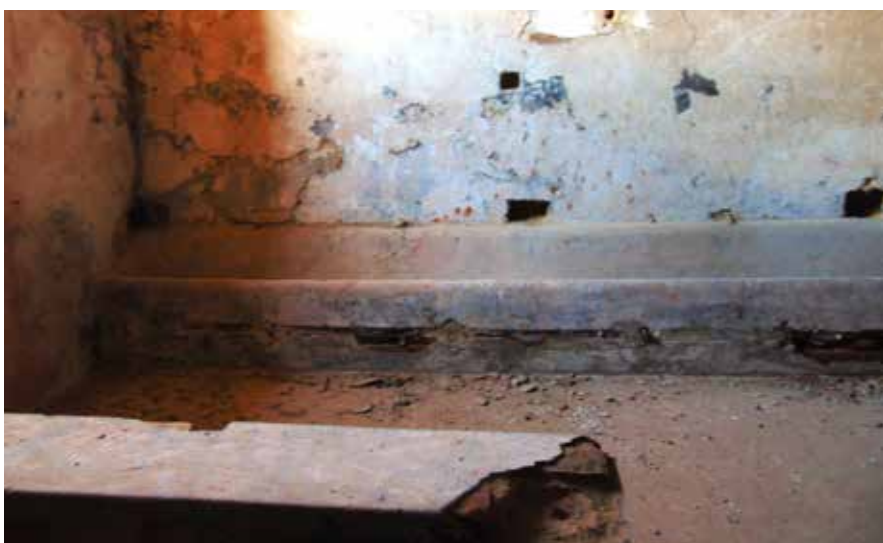
Obr. 3. Zákupy, zámek, část interiéru velkého chléva se žlabem v severním křídle hospodářského dvora (foto autor 2024).
