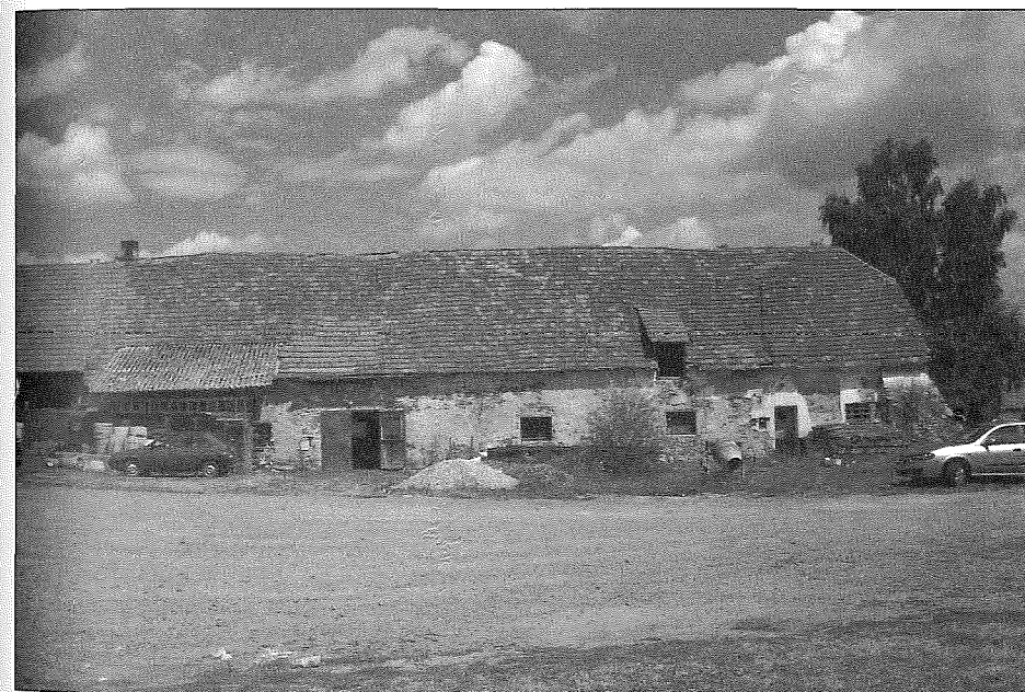
Obr. 4 – Dvorní (jižní) průčelí objektu (foto autorka)
