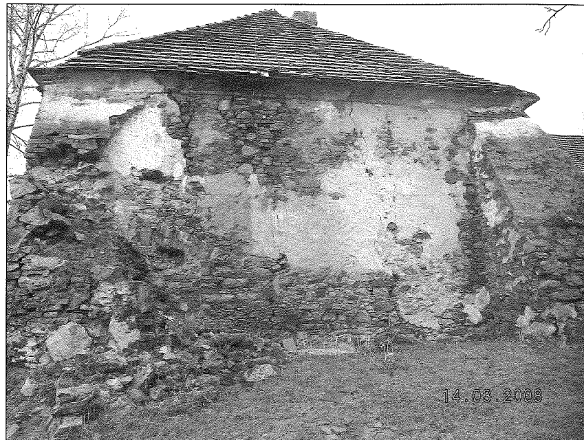
Obr. 6 – Detail severního průčelí se zazděným otvorem
