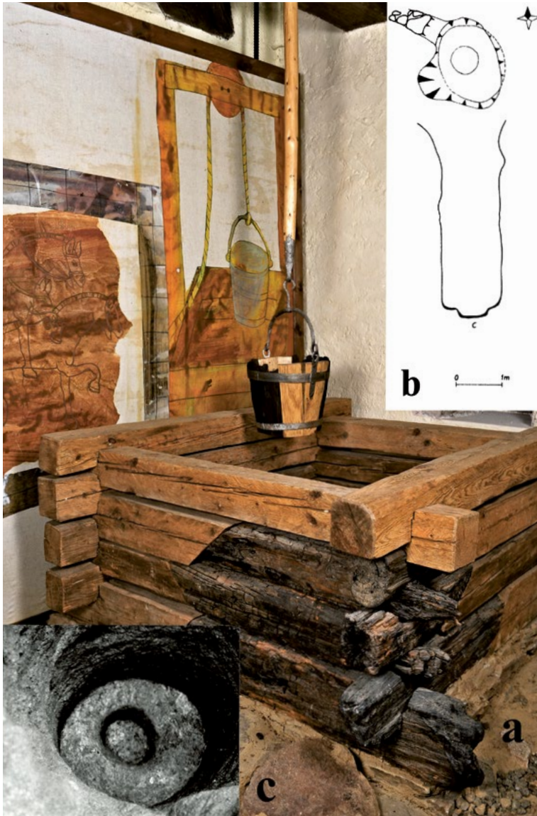
Obr. 30: a) Sezimovo Ústí - levobřežní předměstí, Výzkum AÚ AVČR, Miroslav Richter, Nález studny s povrchovým dřevěným roubením, kovaným okovem zavěšeným na táhlu vahadla opatřeného hákem s tulejí, usedlost II, (bývalá expozice HM, Život a práce středověké společnosti, rekonstrukce studny, foto Z. Prchlík); b, c) ZSO Kravín, kat. Turovec, výzkum Rudolf Krajíc, studna 13. stol. s odkalovačem na dně, řez a foto dna Z. Prchlík.
