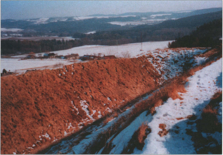
Obr. 12. Hrad Lichnice. Hradní příkopy. Hradní příkop (vnitřní) v jihovýchodní části hradu. Za horní hranou valu okraj obce Podhradí. Současný stav. Snímek Jaroslav Teplý.
