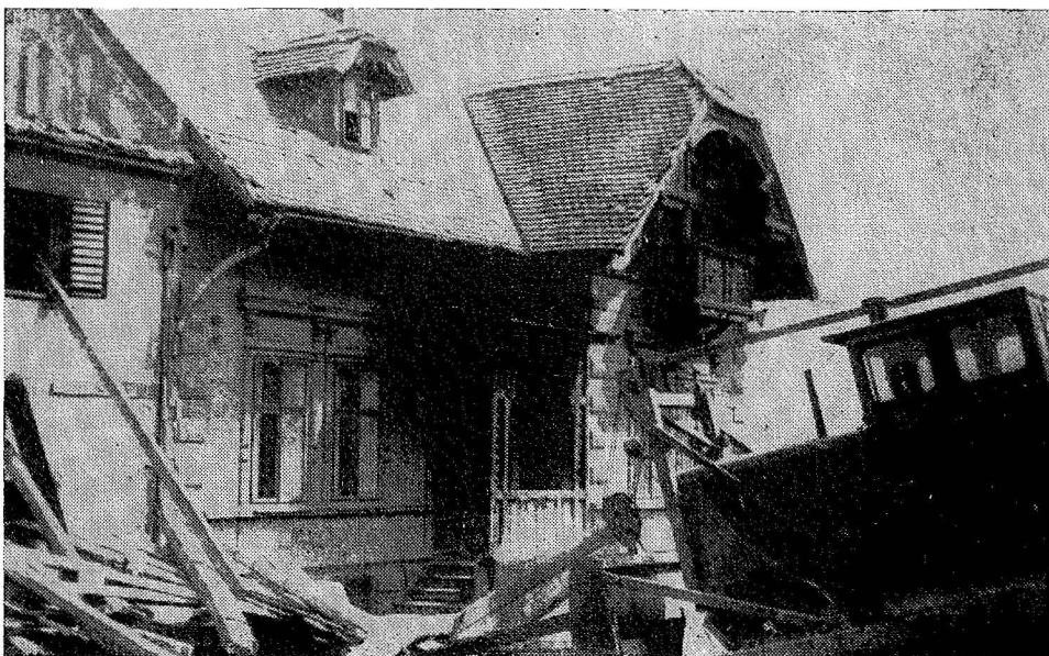
Obr. 2. Pohled na objekt čp. 218 a část objektu čp. 31 při demolici. Foto Ctibor Šilhan.
