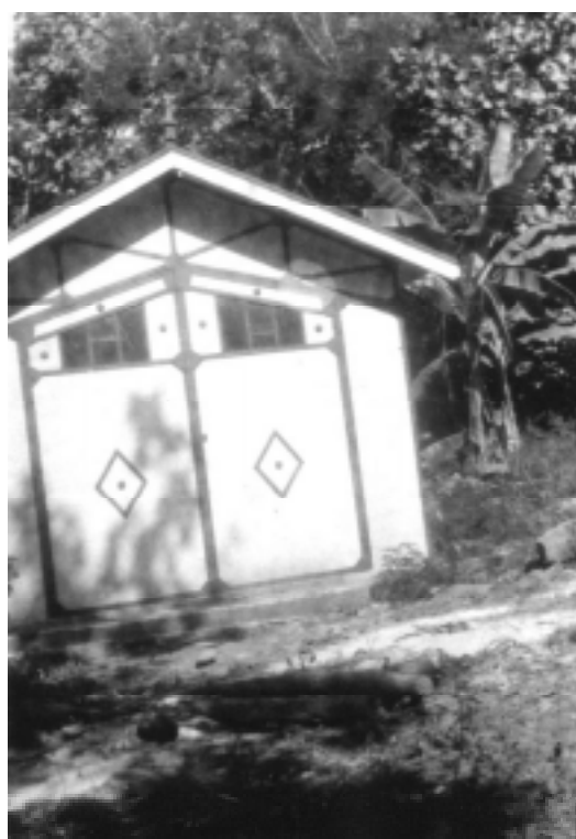
Nejlepší domek v Taiohae – ocelová konstrukce, stěny everitové
