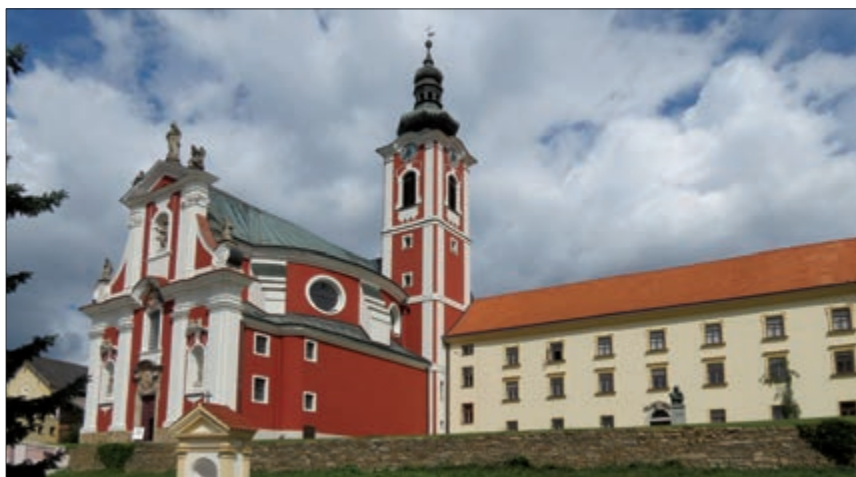
Pohled na jižní frontu bývalého kláštera karmelitánů, dnes zámku v Pacově. Někdejší dlouhodobé místo pobytu hraběnky ze Zdáru. Vlevo je bývalý klášterní kostel sv. Václava. Foto autor.
