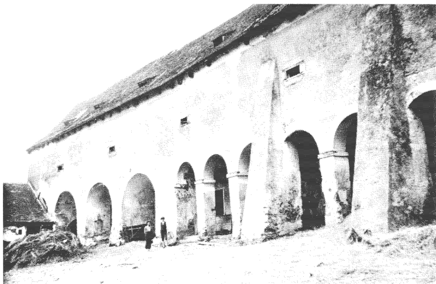
Obr. 8: Severní část dvorního průčelí. Na starší fotografii J. Broukala dobře patrný rozdíl ve velikosti opěrných pilířů starší a mladší části. (HM, Bo č. 94).
