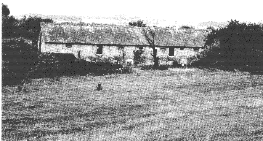
Obr. 15: Východní průčelí renesanční budovy.
