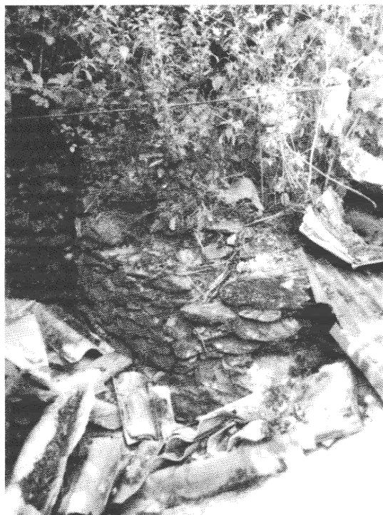
Obr. 18: Část bašty Petráňky při severním průčelí pozdně gotické budovy.
