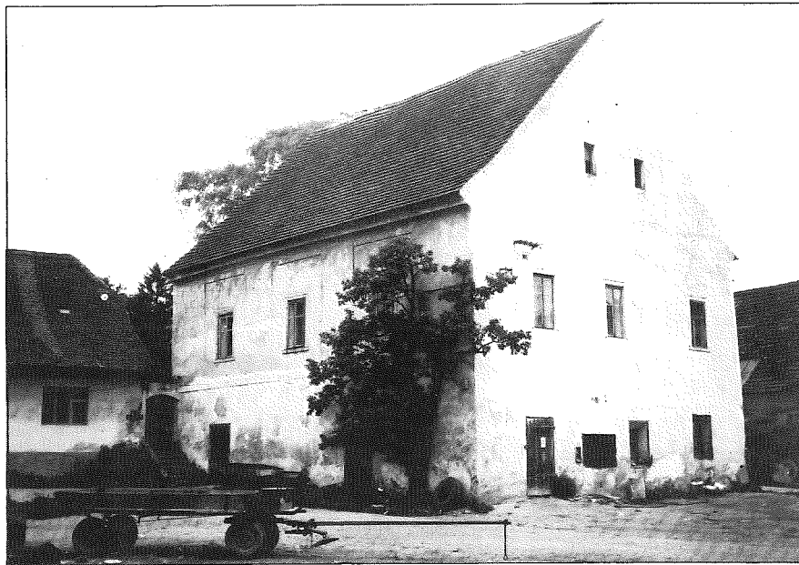
Obr. 9: Dolní Hořice, pohled na jižní průčelí renesanční tvrže (stav roku 1972, foto P. Fiedler).
