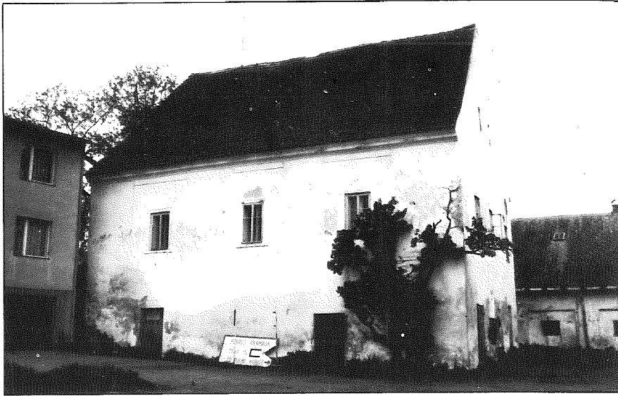
Obr. 8: Dolní Hořice, západní průčelí renesanční tvrže (stav roku 1994, foto autor).
