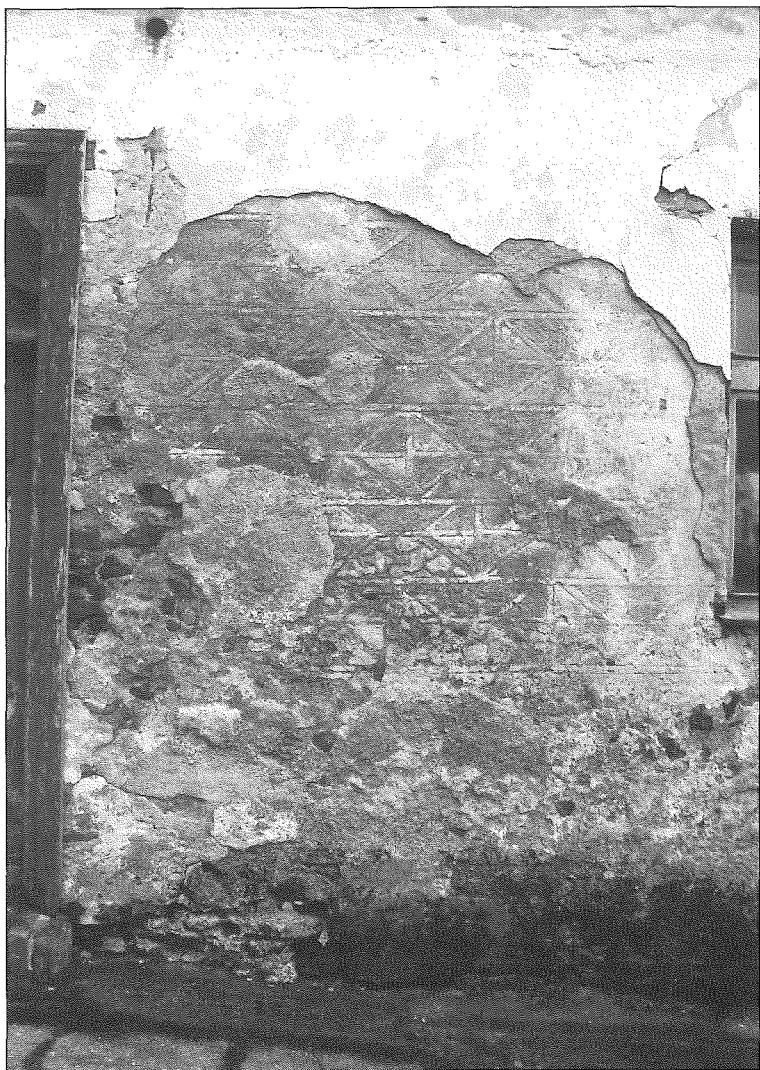
Obr. 6: Dub (Tábor), zbytky sgrafitové omítky poblíž hlavního vstupu. Stav 8. července 2000, foto autor.
