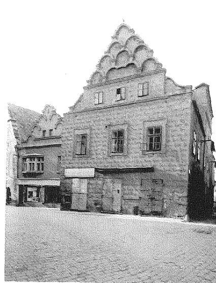
Obr. 1: Pražská ulice, objekt čp. 155, před rekonstrukcí. Stav z roku 1950. (SOKA Tábor, Inženýrská organizace města Tábor. Foto F. Stöber)
