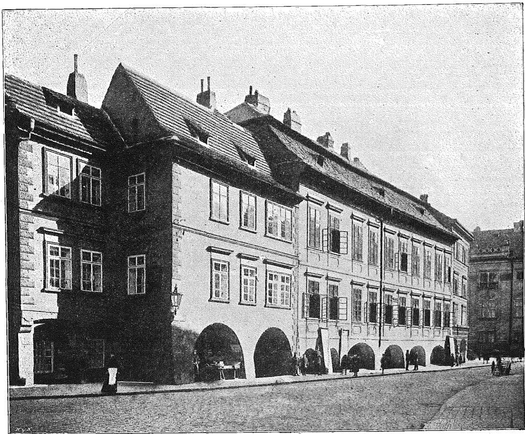
DŮM HRABĚTE J. P. STRAKY NA MALTÁNSKÉM NÁMĚSTÍ (č. p. 476-III. s loubím o 10ti oknech).
