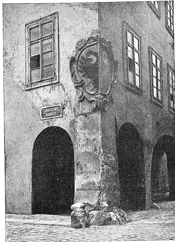
Obr. 4. NÁROŽÍ BÝVALÉHO DOMU čp. 128 (»U ČERNÉHO ORLA«).
