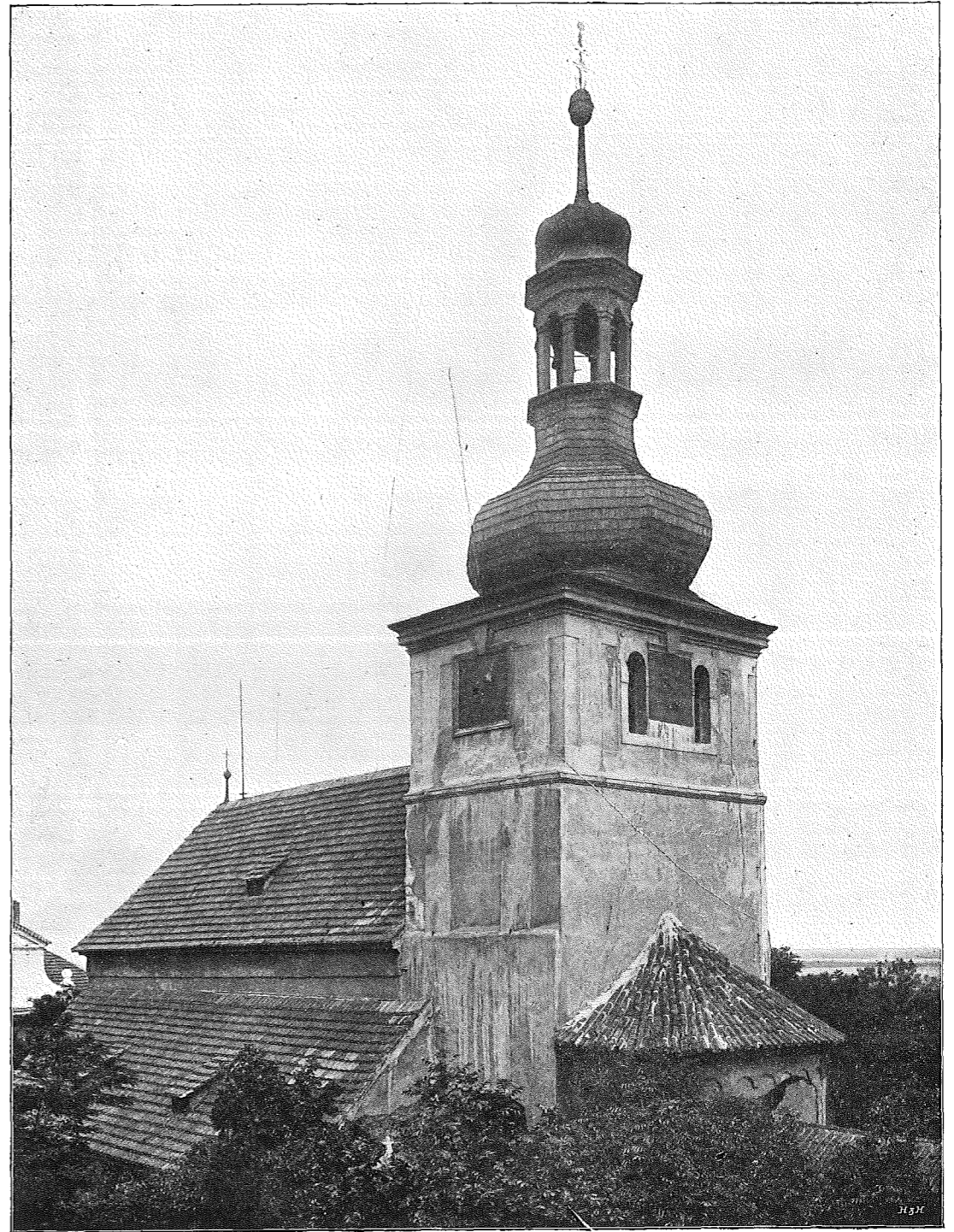
KOSTEL SV. VÁCLAVA NA PROSEKU: POHLED OD STRANY VÝCHODNÍ.
