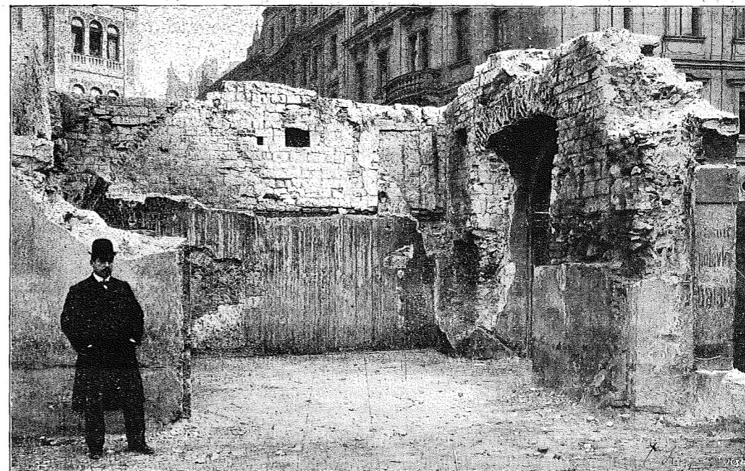
Obr. 12. SEVERNÍ A VÝCHODNÍ STĚNY VELKÉ MÍSTNOSTI DRUHÉHO I PRVNÍHO PATRA Z DOBY ROMÁNSKÉ, znázorněné v řezích C—D a M—N (obr. 8. a 11.) ve stavu ne ještě obnaženém. Viděti lze i stopu klenby gotické, která původní dvě patra románská spojila v jediné patro (přízemek) doby gotické.
