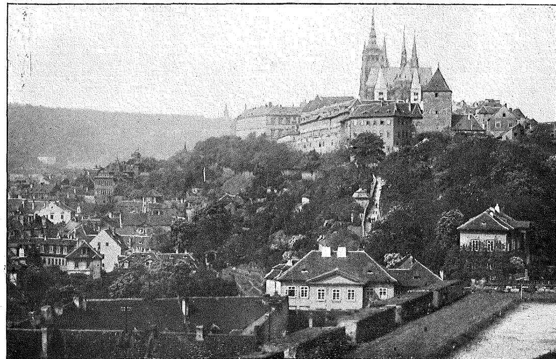
Svah se zahradou fürstenberskou, staré zámecké schody a Opyš. Le jardin Fürstenberg (à gauche de coteau), le „Vieil escalier du Château“ et l' „Opyš“.
