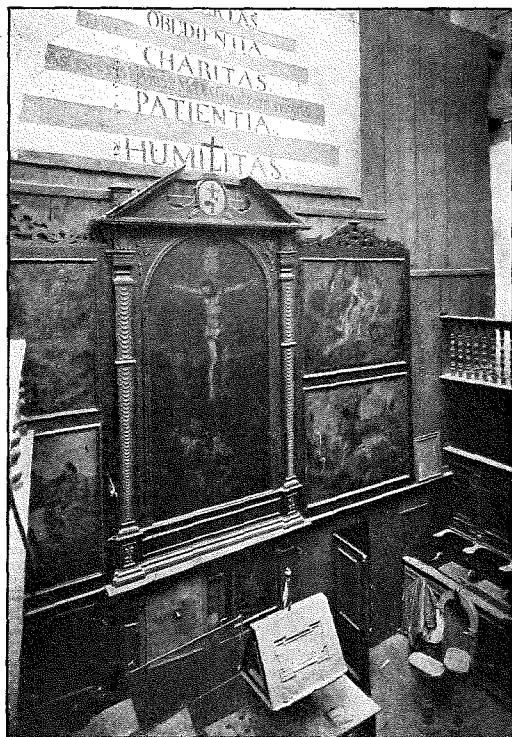
Obr. 63. Část kněžiště za hlavním oltářem. Une partie du chœur, derrière le maître-autel.
