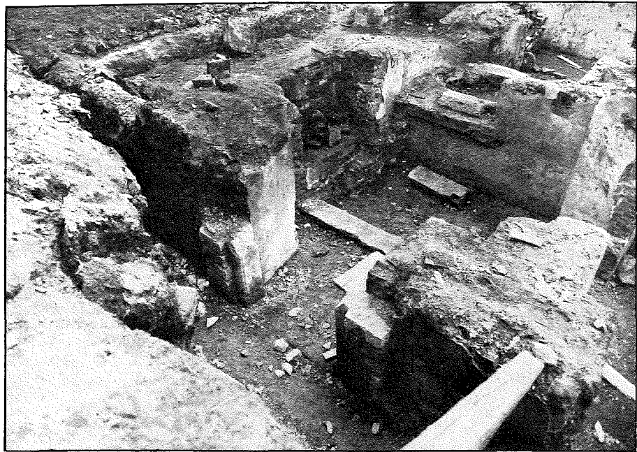
Obr. 32. Pozdější hlavní vchod ve východním průčelí domu. Pohled od severovýchodu. – Portail principal plus récent de la façade est de la maison. Vue du côté nord-est.
