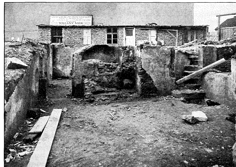
Obr. 36. Topeniště a jižní vchod do malého vřetenového schodiště v původním vestibulu. Pohled od jihu. – Chauffe et l'entrée sud du petit escalier en colimaçon dans l'ancien vestibule. Vue du côté sud.
