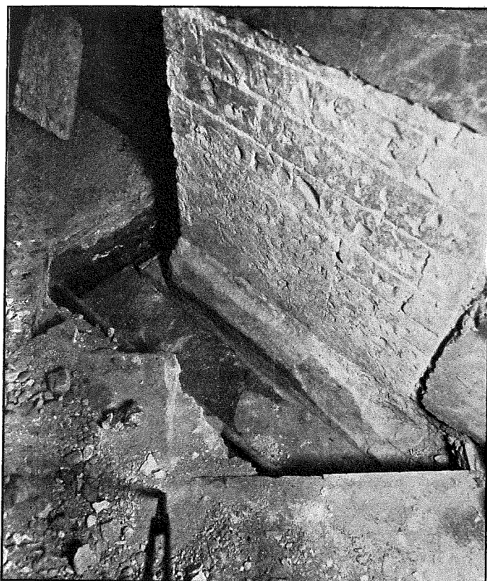
Obr. 52. Kostel sv. Petra. I. pilíř jižní zdi románské hlavní lodi. — Église St. Pierre. 1 er pilier du mur sud de la nef principale romane.
