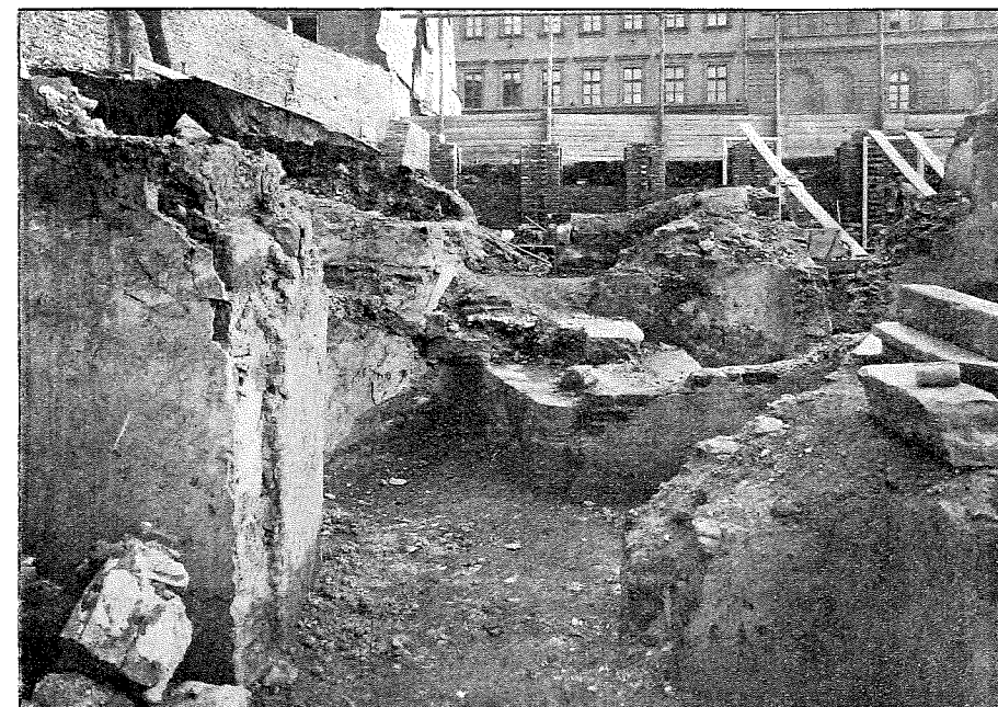
Obr. 35. Původní vstup k hlavnímu vřetenovému schodišti. Pohled od severu. – Ancienne entrée du grand escalier en colimaçon. Vue du côté nord.
